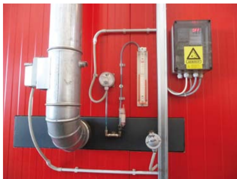
SISTEMA REGOLAZIONE ARIA SECONDARIA SECONDARY AIR ADJUSTMENT SYSTEM
